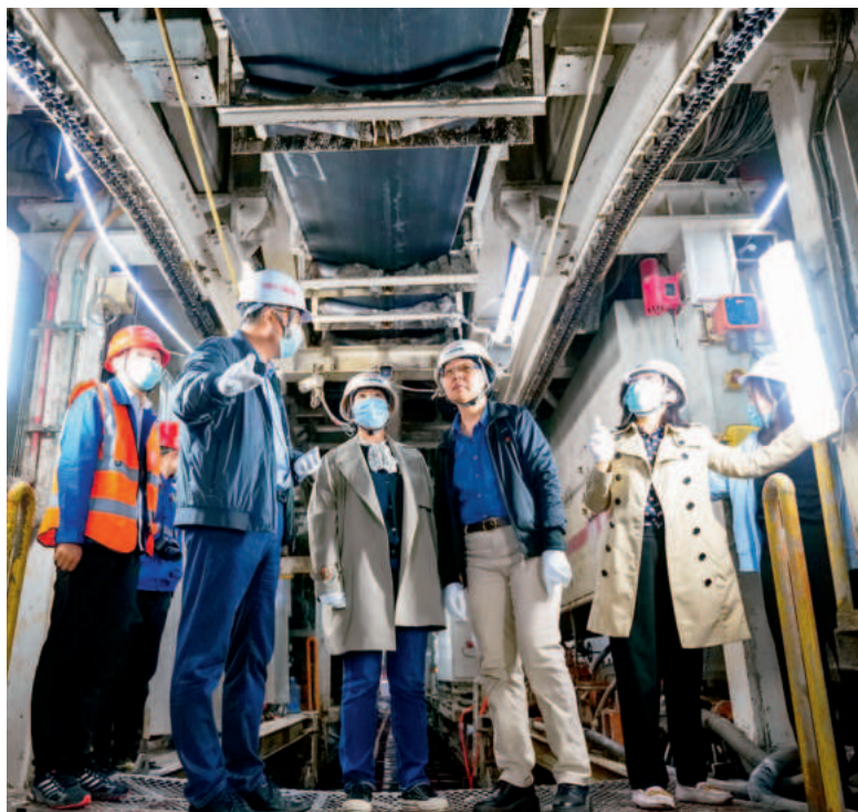
投资一处党支部在轨道交通项目审计中开展“探寻建设路、慰问建设者”活动
