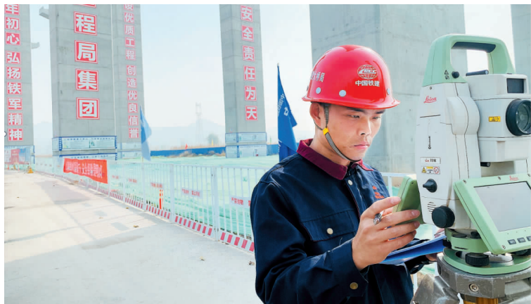
王金宇正在对桥梁结构进行测量
