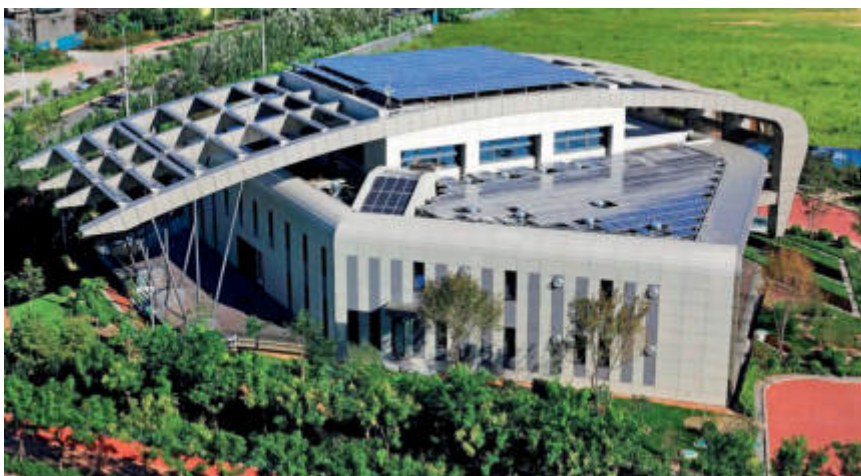
天津首座零碳建筑——中新天津生态城不动产登记服务中心
