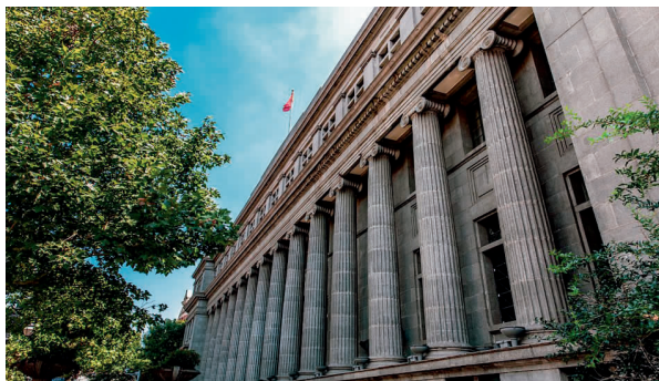
▲历史风貌建筑原开滦矿务局大楼 修缮工程竣工
