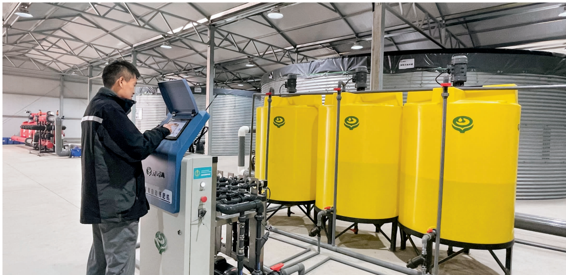
工作人员正在水肥一体化控制设备上设定灌溉时间
