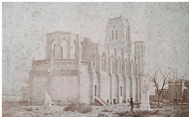
同治八年(1869年)第一次建成的望海楼教堂
